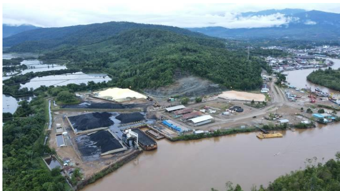
バラタン港湾設備。左側に積み下ろされた石炭が見える（マ リ郡／2022年7月／WALHI南スラウェシ）
