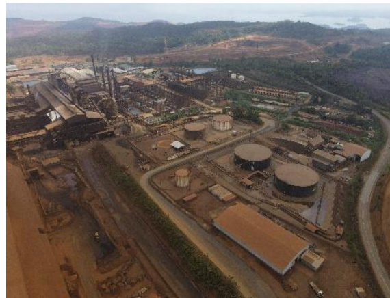
ニッケルマット製造設備（2022年10月／ドローンで撮影 協力：WALHI 南スラウェシ）
